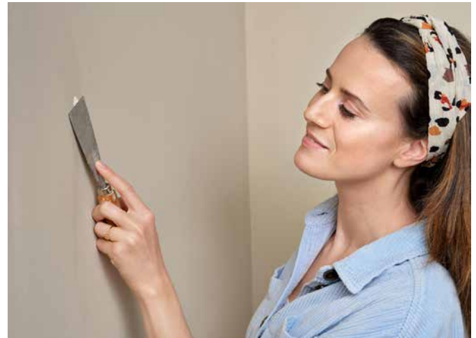
Löcher in Wänden sind mit der gebrauchsfertigen Spachtelmasse aus der Tube in kurzer Zeit gefüllt. (Foto: Molto/Akzo Nobel/akz-o)
